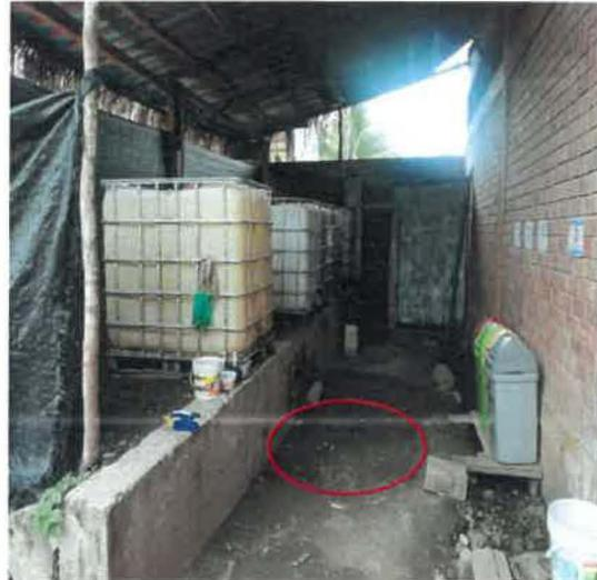
Almacén de combustible del campamento central del C.P de Triboline, se evidencia derrame de combustible sobre el piso. Y válvula de cubo fuera de estándar.
