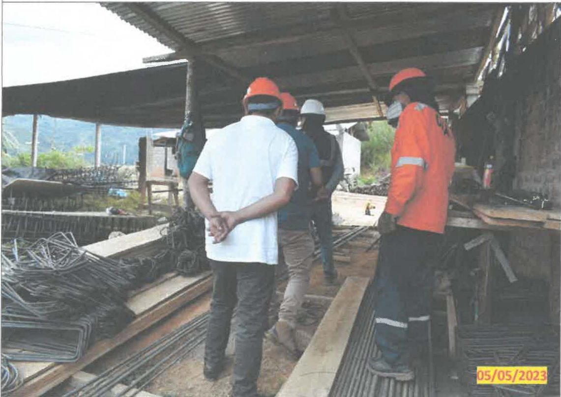
IMG. 04.- Se aprecia la habilitación de acero para la infraestructura educativa.
