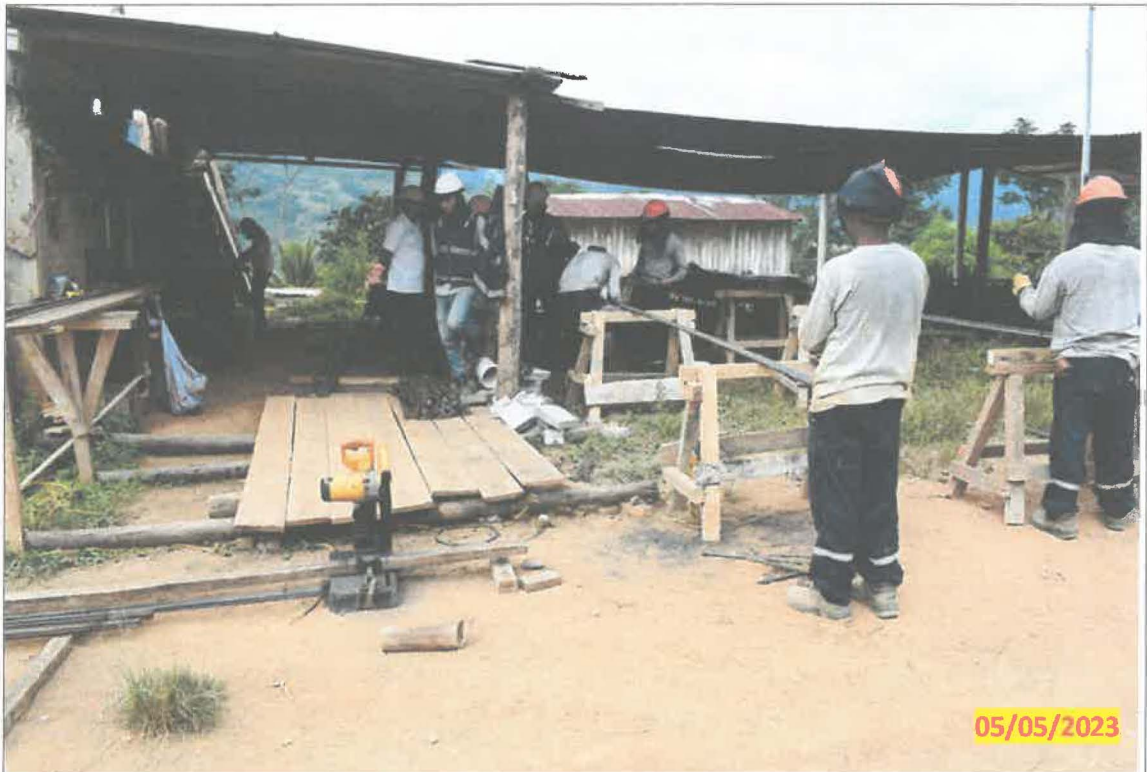
IMG. 05.- Vista de la verificación del almacenamiento de los aceros.
