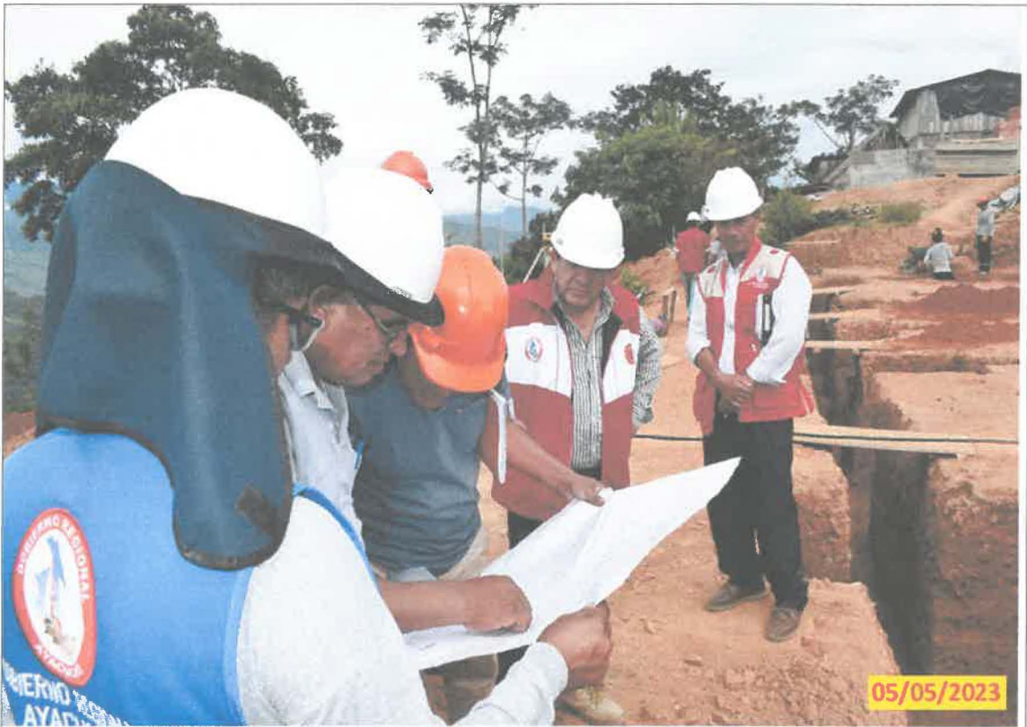
IMG. 03.- Revisión del proceso constructivo en la partida de excavación de zanja para la cimentación de la infraestructura educativa..
