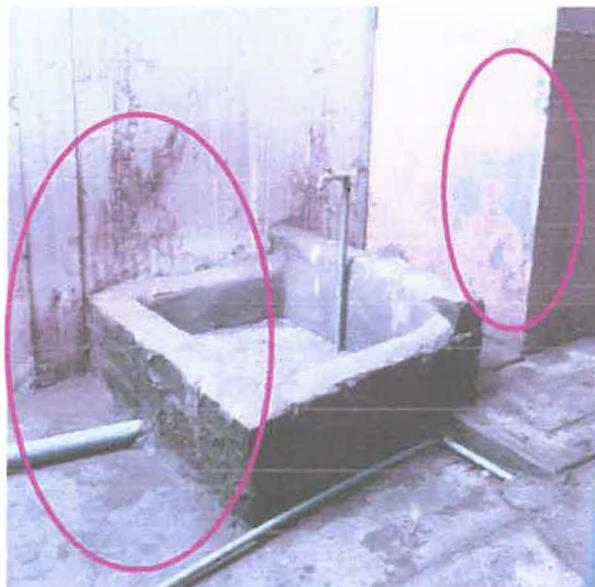
Imagen 19: paredes y pisos del área de lavandería de cemento, con tuberías expuestas y presencia de mohos, que genera riesgo de contaminación a las ropas hospitalarias.
