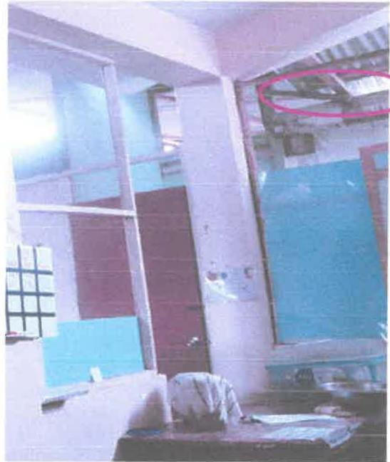
Imagen 11: área de cocina y comedor con aberturas de techos de calamina que genera el riesgo de contaminación del ambiente.
