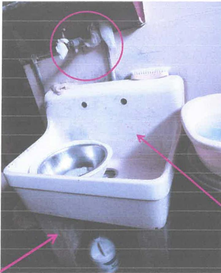
Imagen 13: lavadero de área de comedor con cañería cubierta de gasa, con presencia de plástico y otros agentes, cuyas características no cumple con la normativa.
