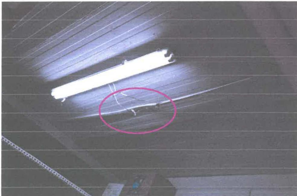
Imagen 03: luminaria con conexiones sin protección
