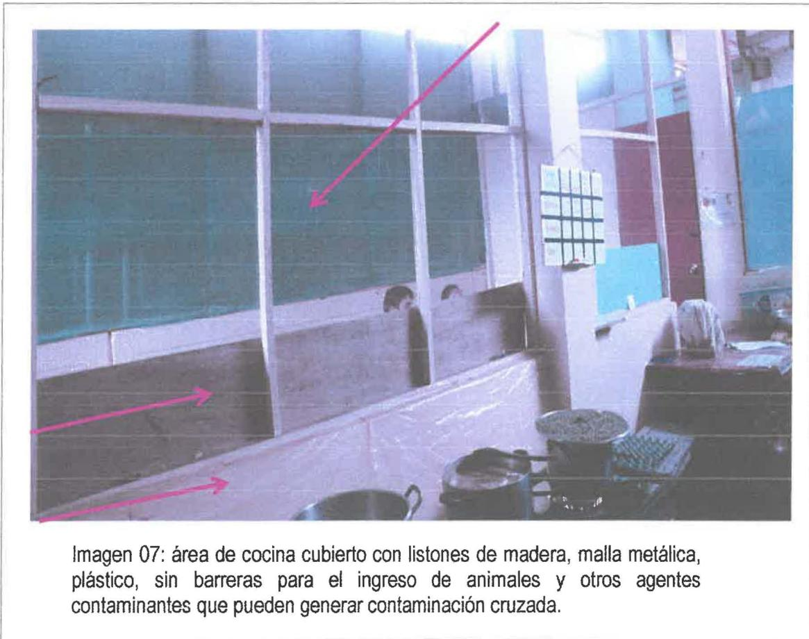
Imagen 07: área de cocina cubierto con listones de madera, malla metálica, plástico, sin barreras para el ingreso de animales y otros agentes contaminantes que pueden generar contaminación cruzada.
