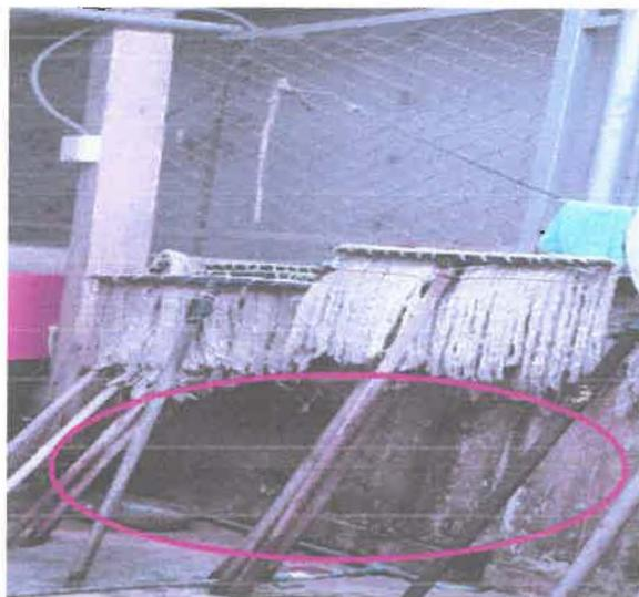
Imagen 18: paredes del área de lavandería con presencia de mohos que genera el riesgo de contaminación cruzada a las prendas hospitalarias.
