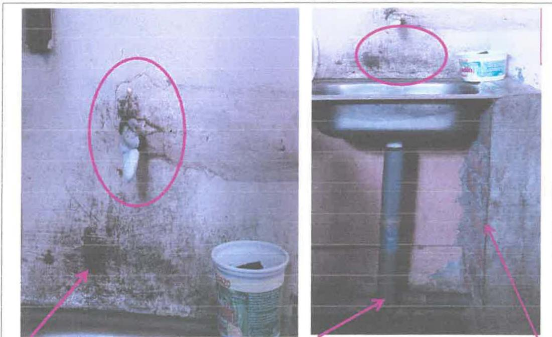
Imagen 12: cañería y lavadero del área de cocina en estado de deterioro, cubierto con gasa con presencia de manchas de color marrón que genera el riesgo de contaminación cruzada.
