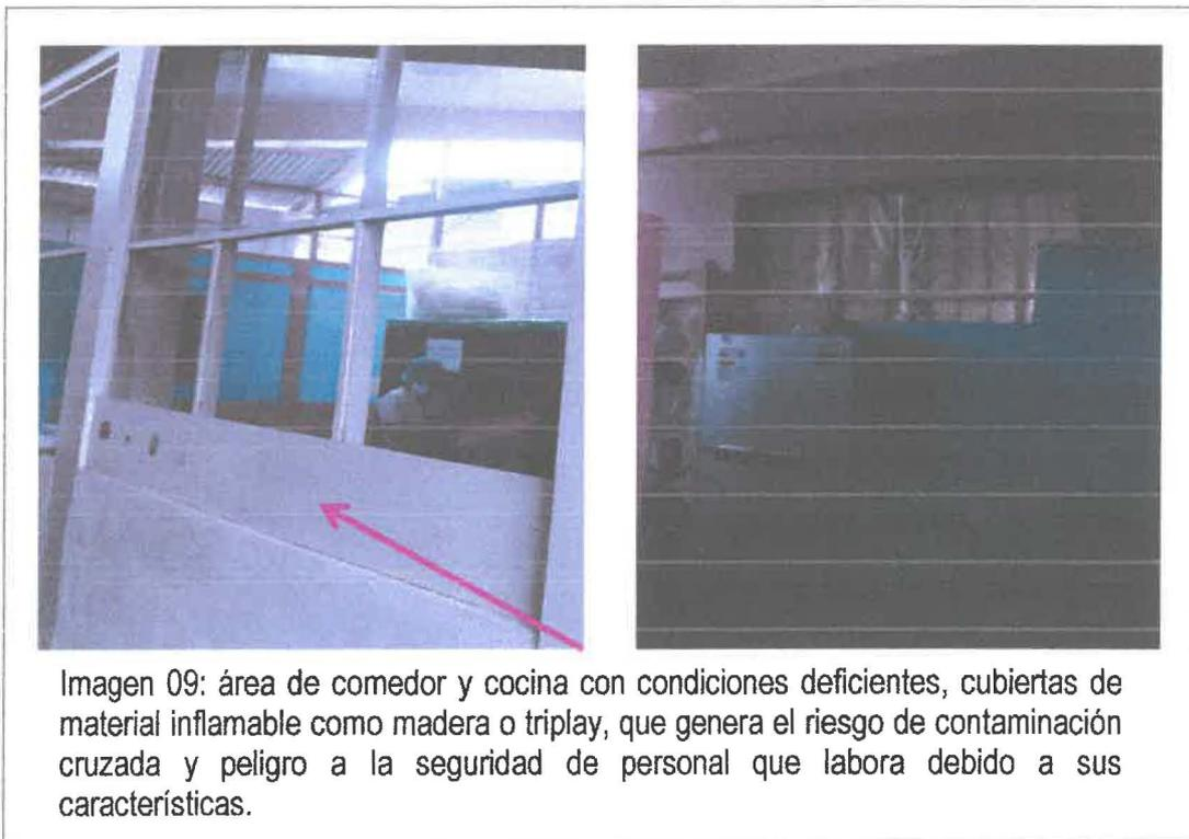
Imagen 09: área de comedor y cocina con condiciones deficientes, cubiertas de material inflamable como madera o triplay, que genera el riesgo de contaminación cruzada y peligro a la seguridad de personal que labora debido a sus características.
