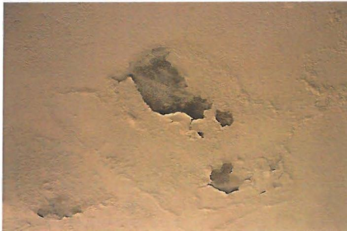
Vistas fotográficas del descascaramiento de pinturas, producto de la humedad constante, en la parte norte del techo de la gradería del segundo nivel.
