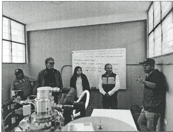
Vista fotográfica N° 09 y 10: Equipo generador de nitrógeno líquido se encuentra inoperativo por motivos de mantenimiento del estabilizador
