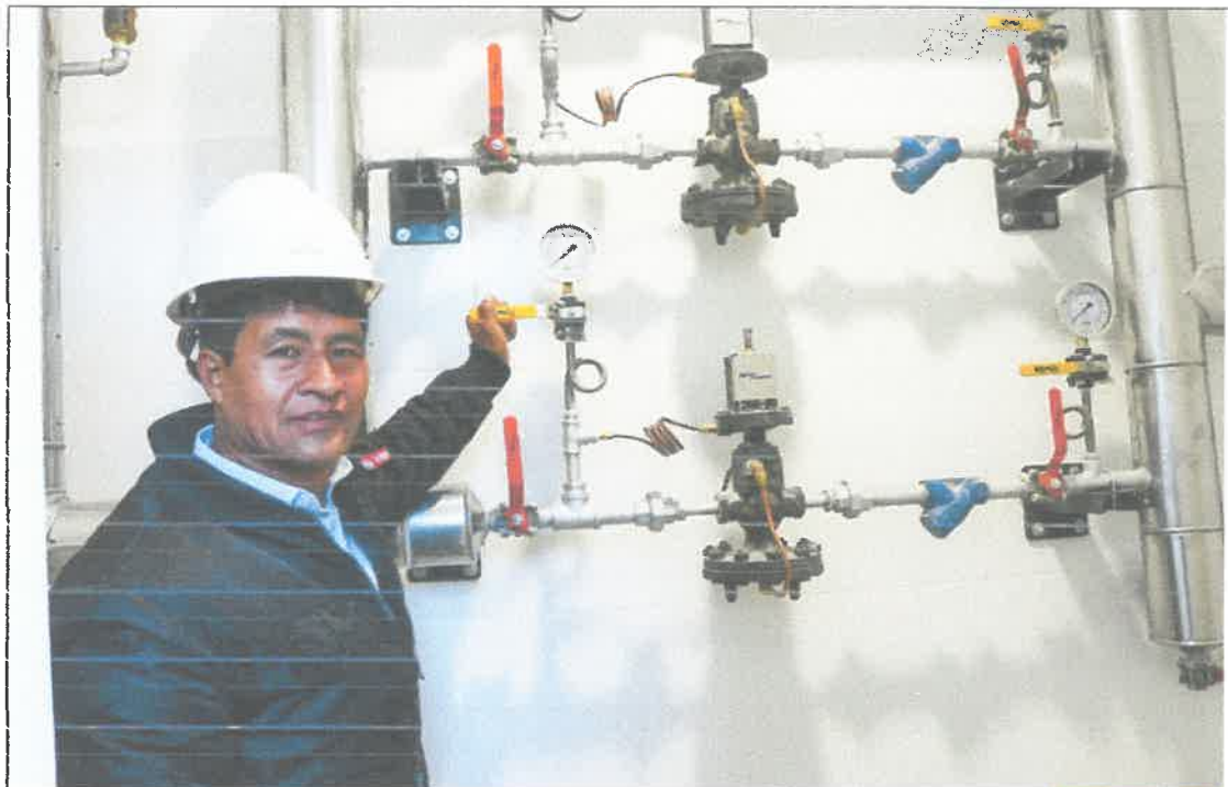
IMG. 06.- Verificando las válvulas de control de la casa de maquinas
