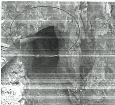
Fotografía N° 01 y 02. Bocamina de acceso principal a labores no cuenta con fortificación Base Legal: Decreto Supremo N°024-2016-EM, Reglamento de Seguridad Y Salud Ocupacional en Minería.
