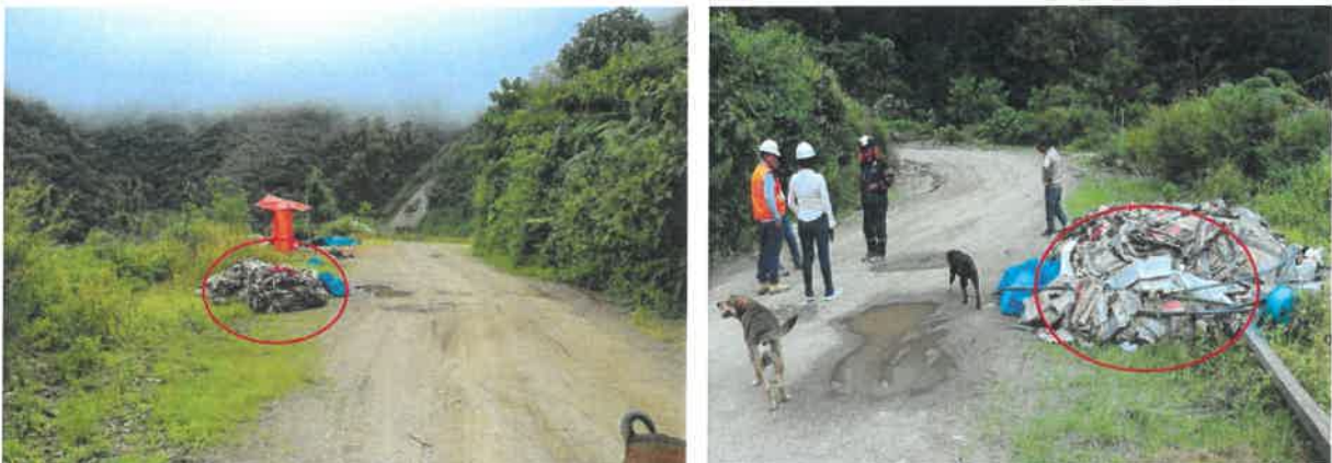
Almacenamiento inadecuado de bolsas de cemento vacias sobre la via
