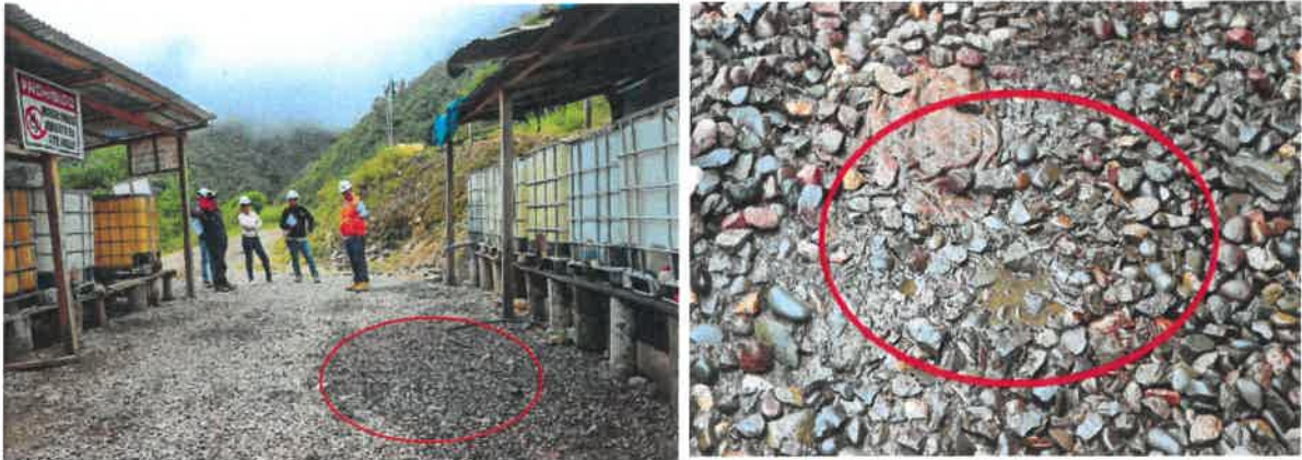
Almacén de combustible del campamento del frente Putis, se evidencia derrame de combustible sobre el piso
