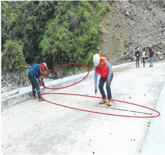
Loza de puente Apulema de 5.00 m. de longitud, así mismo no cuentan con los estribos.
