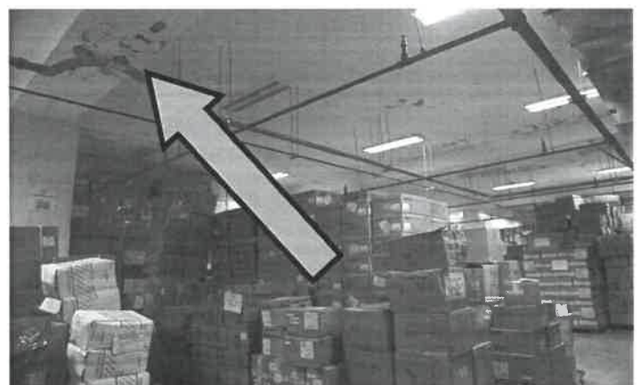
FILTRACIÓN EN COLUMNA DE CONCRETO QUE AFECTA LA HABITABILIDAD
