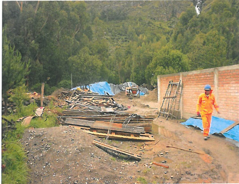
Inadecuado almacenamiento de agregados
