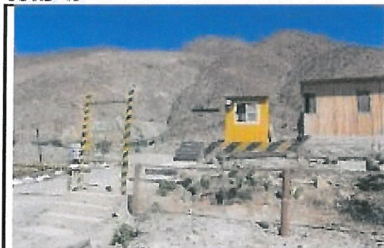
Garita de Control de la Labor Minas el Dorado, sin ningún tipo de señales de prevención
