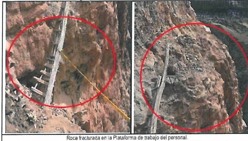
Roca fracturada en la Plataforma de trabajo del personal.
