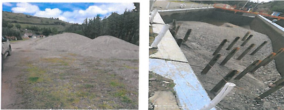
Imagen 03: desarenado en la bocatoma de Chiellarazo-Chuschi-Cangallo
