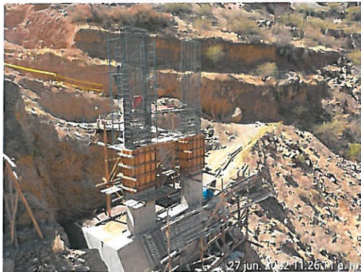
Foto 7: Estructura de anclaje derecho vaciada y encofrado de pilares (Aranhuay)
