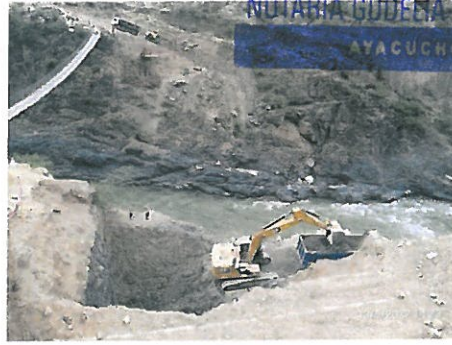
Foto 4: Excavación anclaje izquierdo (Churcampa)
