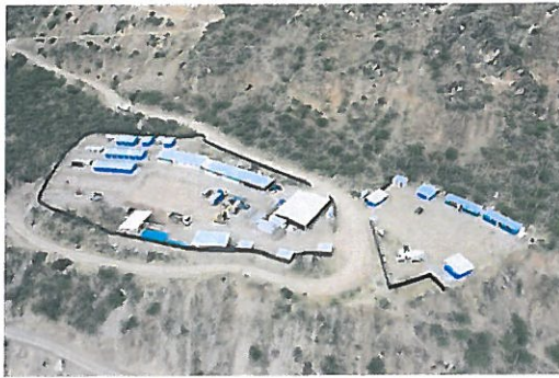
Foto 3: Trazo y replanteo de accesos y puente
