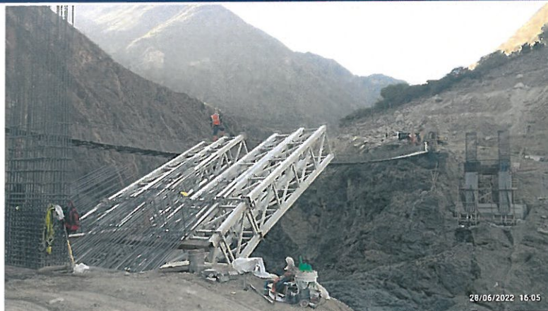
Foto 9: Montaje de falso puente
