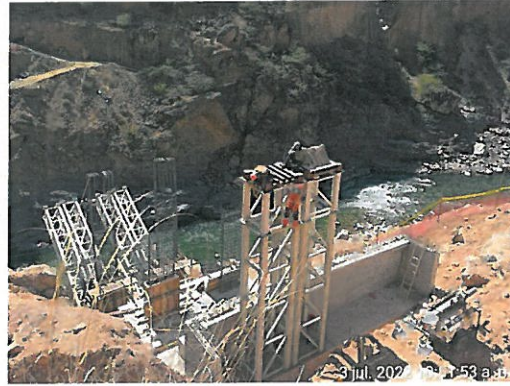
Foto 8: Lanzamiento de falso puente lado izquierdo (Churcampa)
