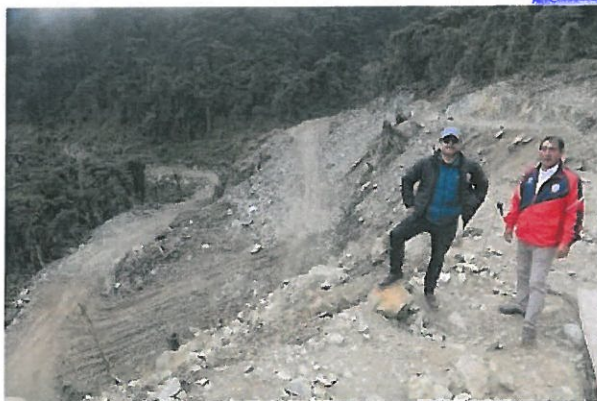
IMG. 12.- Recorrido de la apertura del camino vecinal. Tramo II: Sierra
