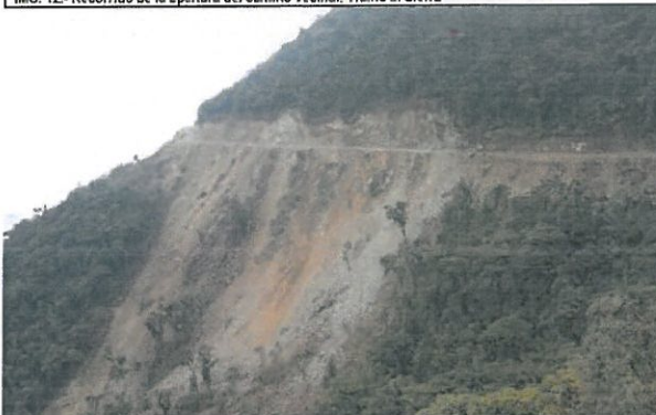
IMG. 12.- Se observa que todo el volumen excedente de las explanaciones ejecutadas y cortes de talud es eliminado al pie de carretera a un costado del camino en ejecución, debiendo ser éste dispuesto en un botadero acondicionado para tal fin, autorizado por el Supervisor y ubicado por un especialista ambiental, conforme lo establece el procedimiento de la normativa ambiental aplicable. Tramo II: Sierra
