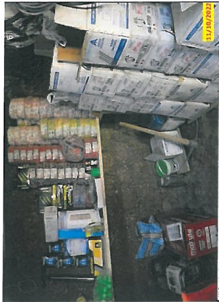
IMG. 10.- Se observa que el almacén de obra no cuenta con tarjetas de control "visite" -C-obra, dificultando el control de la cantidad y movimiento de los materiales y bienes de la obra.
