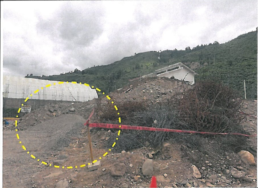
IMG. N°04.- Se evidencia que los agregados no se manejan como materiales independientes, generando contaminación con el desmonte producido por la ejecución natural de la obra, pudiendo modificar su uniformidad y características.
