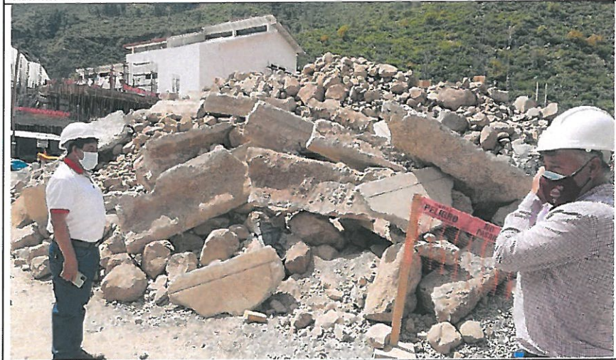
IMG. N°04.- Se evidencia que los agregados no se manejan como materiales independientes, generando contaminación con el desmonte producido por la ejecución natural de la obra, pudiendo modificar su uniformidad y características.
