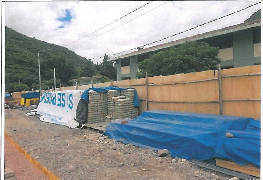
IMG. N°02.- Disposición del almacenamiento de cemento y aceros en obra. El cemento en bolsas no se almacena en un lugar techado, fresco, libre de humedad, sin contacto con el suelo. Se evidencia el apilamiento de más de 10 bolsas. No se almacenan en silos metálicos que impidan el ingreso de humedad o elementos contaminantes. Las barras de acero de refuerzo no se almacenan en un lugar seco, aislado del suelo y protegido de la humedad, tierra, sales, aceite y grasas.
