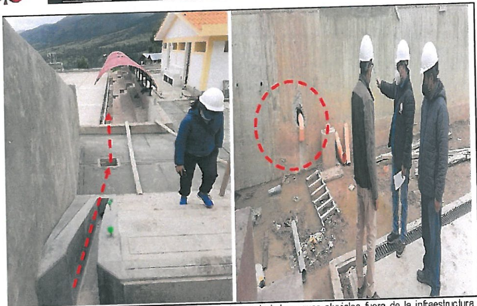
IMG. N°02.- Se evidencia que por la necesidad de conducir las aguas pluviales fuera de la infraestructura educativa a través de canales abiertos, y tuberías de PVC cubiertos, estos afectarían el proyecto arquitectónico inicial, el diseño de la edificación y las áreas de uso por la modificación parcial de las dimensiones de la escalera de acceso al Módulo C, afectando también los cánones estéticos predeterminados.
