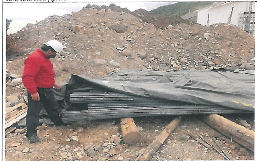
IMG. N°02.- Disposición del almacenamiento de cemento y aceros en obra. El cemento en bolsas no se almacena en un lugar techado, fresco, libre de humedad, sin contacto con el suelo. Se evidencia el apilamiento de más de 10 bolsas. No se almacenan en silos metálicos que impidan el ingreso de humedad o elementos contaminantes. Las barras de acero de refuerzo no se almacenan en un lugar seco, aislado del suelo y protegido de la humedad, tierra, sales, aceite y grasas.
