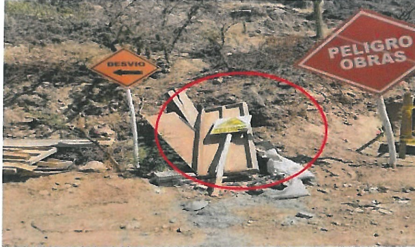
IMAGEN 09: Se observa el mal almacenamiento de material de eliminación con respecto a las maderas que solo están colocadas en un punto, incumpliendo el componente de mitigación ambiental.
