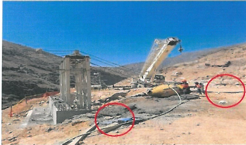
IMAGEN 07: Se observa que ahí material de eliminación en varios puntos donde se viene realizando los trabajos.
