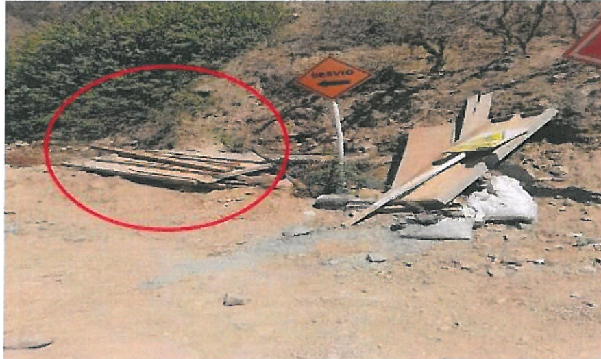
IMAGEN 09: Se observa el mal almacenamiento de material de eliminación con respecto a las maderas que solo están colocadas en un punto, incumpliendo el componente de mitigación ambiental.
