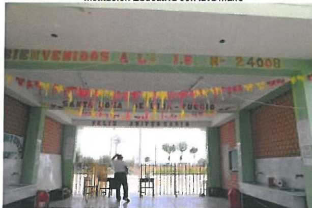
Puerta de ingreso de la I. E. N° 24008
