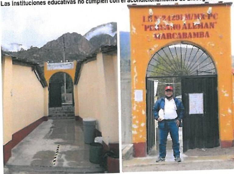
Puerta de Ingreso de la I. E. 24291
