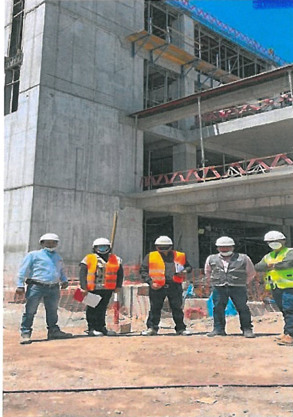
Imagen 01: Se observa visita de la consejera por la provincia de Huanta a la obra del Hospital.
