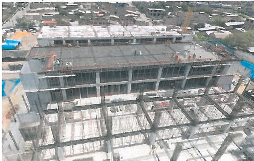
Construcción del Hospital de la Obra: "Mejoramiento y Ampliación de los Servicios de Salud, del Hospital de Apoyo de Huanta Daniel Alcides Carrión, Distrito de Huanta, Provincia de Huanta, Departamento de Ayacucho". CUI N° 2194679.
