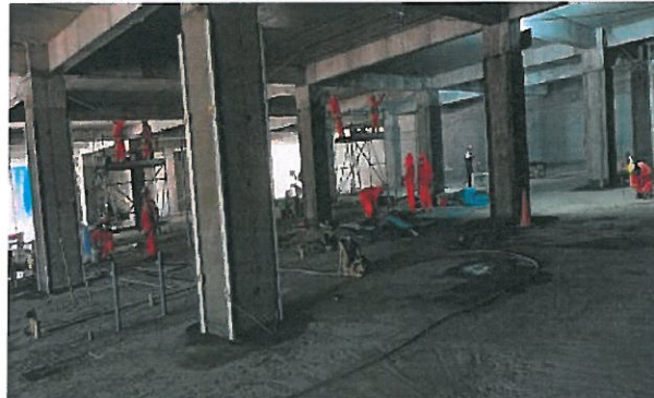
Imagen 02: Se observa los trabajos de tarrajeo en vigas y columnas.
