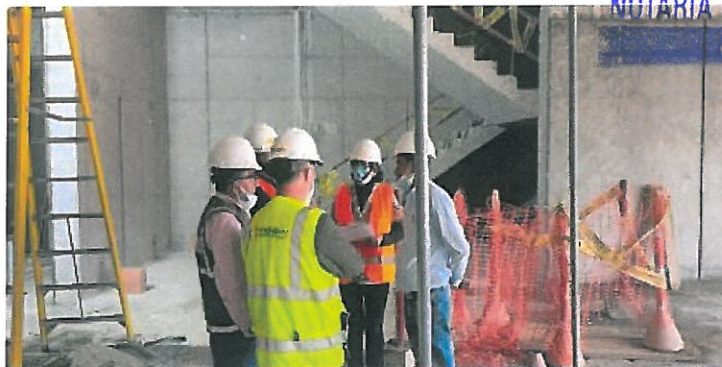
Imagen 08: Se observa la reunión con los encargados del proyecto y verificando la asistencia del personal técnico en obra.
