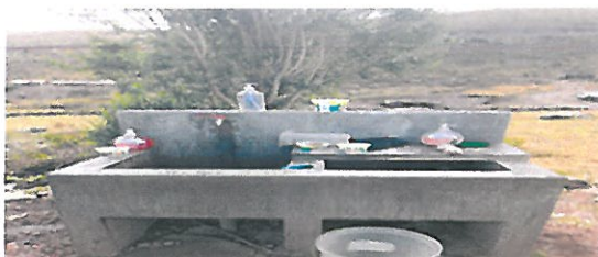
Imagen 06: Se observa el lavadero completamente obstaculizado y no es solamente para el lavado de manos sino se observa que también están lavando cosas de la cocina, por todo eso se estaría incumpliendo con lo ya descrito
