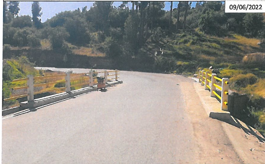
IMG. 08.- Se observa personal contratado por la empresa Loaysa Contratistas Generales SRL, en trabajos de repintado de barandas en puente Km. 04+640.
