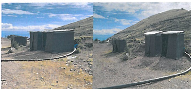
Imagen 08: Se observa que las letrinas no tiene ningún tacho de recolección de residuos, tampoco tiene ninguna señal informativa de que son muy importantes. Tampoco se observa un sistema de ventilación de la letrina. También se observa que cruza una manguera obstruyendo el libre tránsito.
