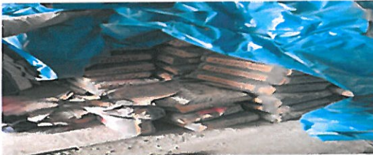
Imagen 09: Se observa el deterioro del material, que ya se esta perdiendo.
