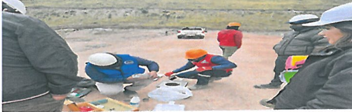
Imagen 24: Se observa que los equipos con los que se viene realizando los ensayos de campos no tiene certificado de calibración que se pudo corroborar insitu.
