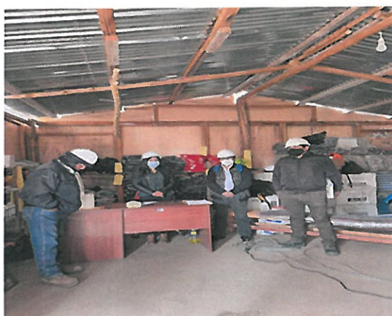
Imagen 01: Se observa que la supuesta oficina técnica esta dentro del actual almacén de obra.
