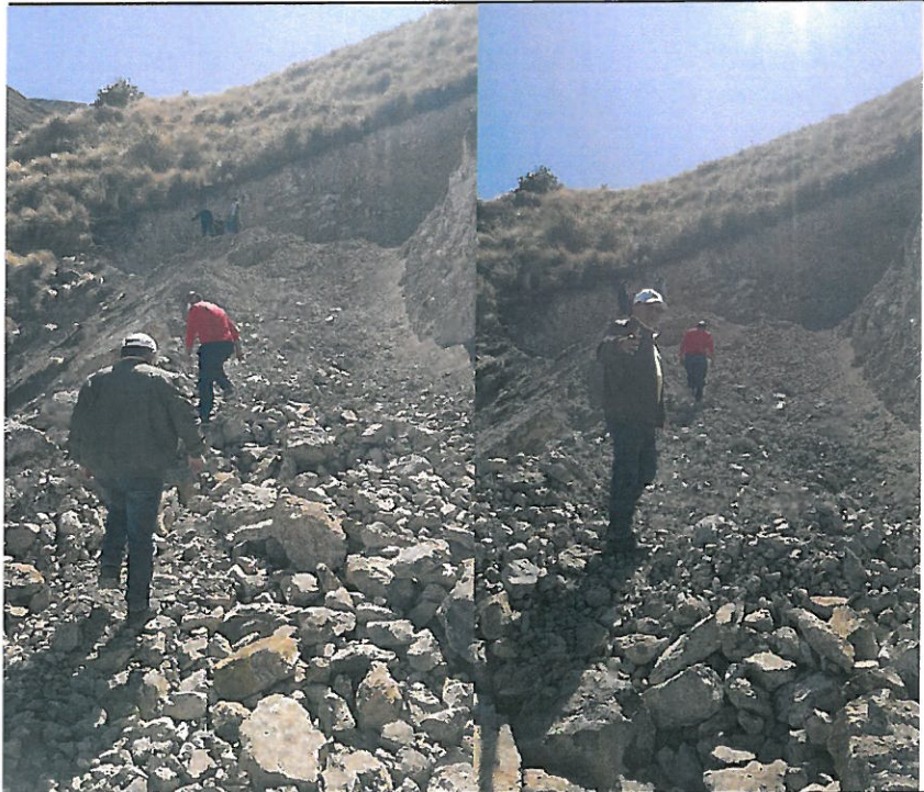
IMG. 04.- Se verifico el desarrollo de partidas ejecutadas de Movimiento de Tierras: Excavación en material suelto, excavación en roca fracturada (suelta) y excavación en roca fija, de la trocha carrozable desde el Km. 0+000 al Km 0+480 del tramo Ccalla Ccalla -Canopata (L=2.613km) observándose tramos con pendientes muy pronunciadas. Se deberá evaluar pendientes máximas en trochas carrozables según normativa.
