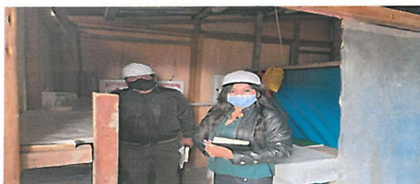
▶ Imagen 05: Se observa que el ambiente destinado para el control covid-19 no cuenta con todos los implementos, a pesar que se viene realizando las valorizaciones correspondientes de la partida.
