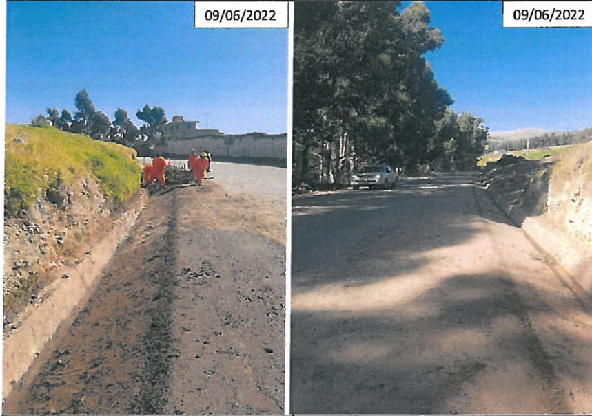
IMG. 06.- Se observa personal contratado por la Empresa Loaysa Contratistas Generales SRL, en trabajos de limpieza de cunetas a lo largo del Km. 0+000 al 5+060.
