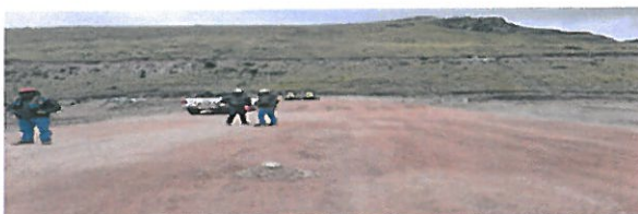
Imagen 21: Se observa el punto destinado para realizar el ensayo de densidad de campo estipulado por los Responsables de obra
